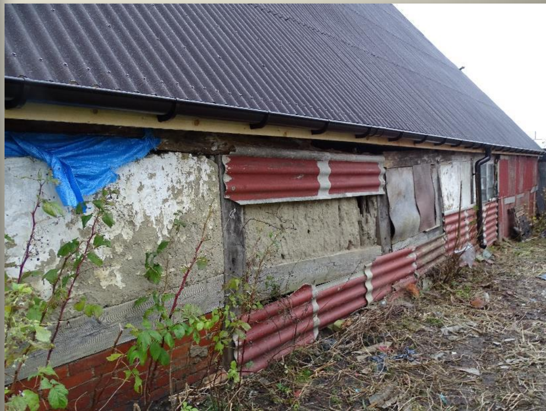
Dach po pracach zabezpieczających
