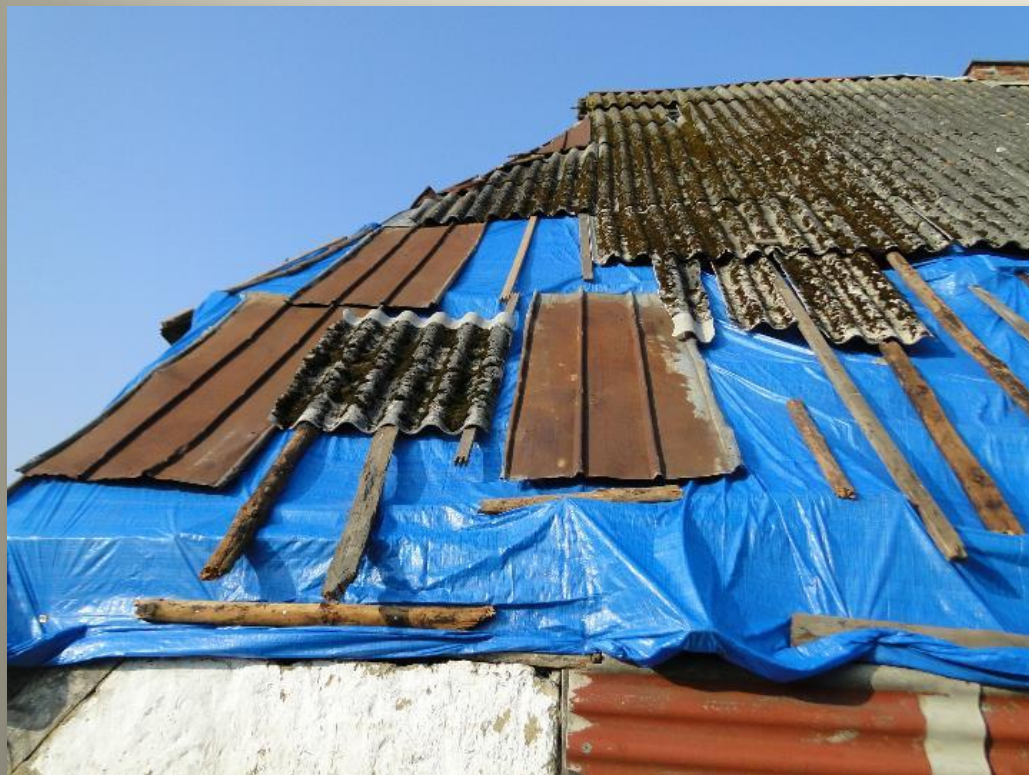
Pokrycie dachu – połać wsch.
