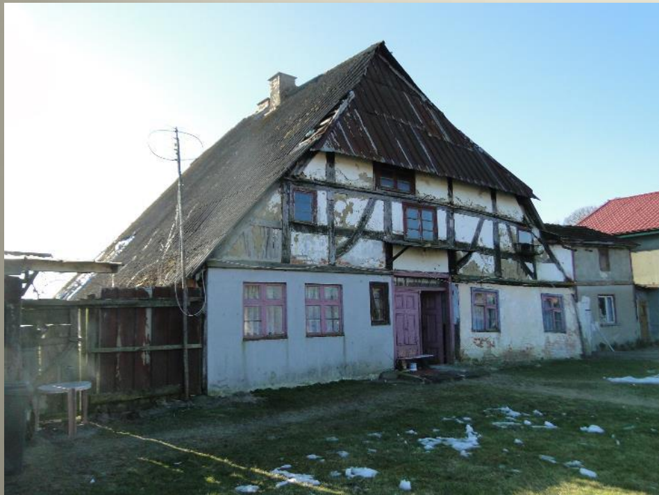
Elewacja frontowa północna
