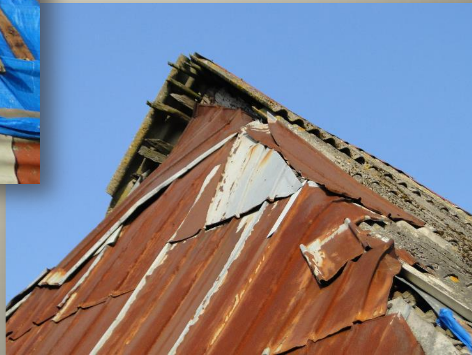
Pokrycie dachu – szczyt płd.
